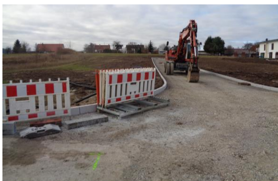
Baustelle Baugebiet „Dietingen-Mitte“
